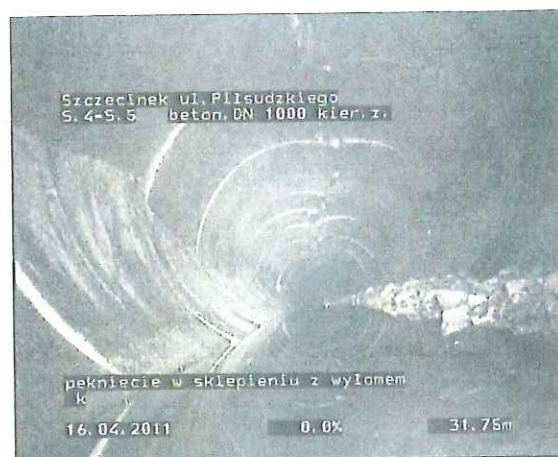
Zdjęcie: D.4_D.5_180411_102457_B.JPG 31,74m, Wyłom wzdłużny, o 12 godzina, KANAŁ SIĘ SKŁADA
