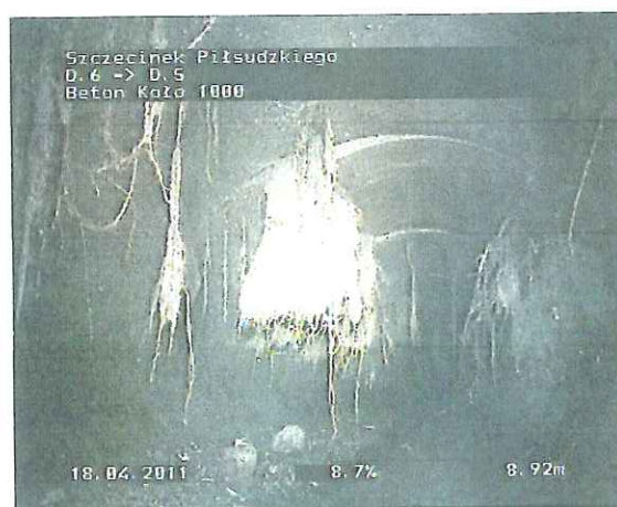
Zdjęcie: D.6_D.5_180411_135249_B.JPG 8,92m, Wyłom wzdłużny, o 06 godzina
