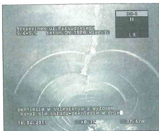
Zdjęcie: D.4_D.5_180411_102547_A.JPG 31,74m, Wyłom wzdłużny, o 12 godzina
