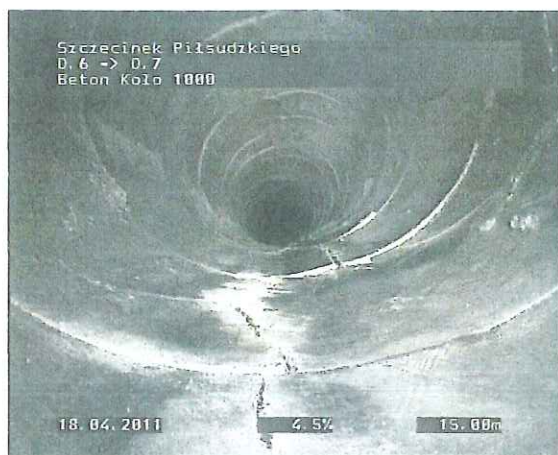
Zdjęcie: D.6_D.7_180411_150530_A.JPG 15m, Pęknięcie wzdłużne, o 06 godzina
