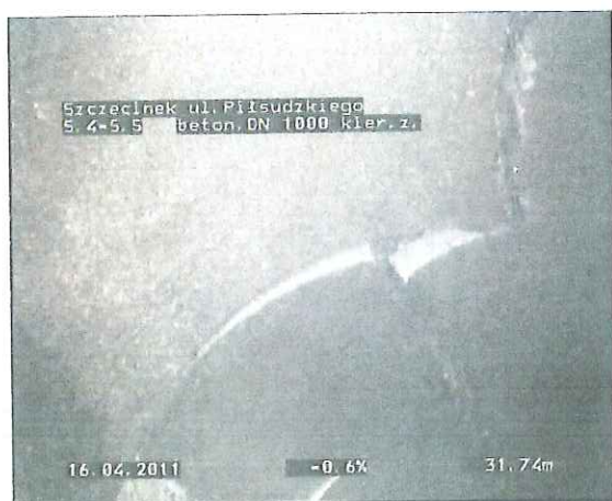
Zdjęcie: D.4_D.5_180411_102451_A.JPG 31,74m, Wyłom wzdłużny, o 12 godzina, KANAŁ SIĘ SKŁADA
