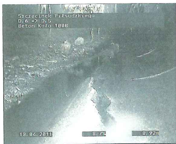
Zdjęcie: D.6_D.5_180411_135223_A.JPG 8,92m, Wyłom wzdłużny, o 06 godzina
