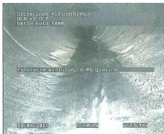
Zdjęcie: D.6_D.7_180411_151002_A.JPG 23,77m, Pęknięcie wzdłużne, o 06 godzina
