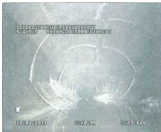
Zdjęcie: D.4_D.5_180411_102718_A.JPG 40,95m, Wyłom wzdłużny, o 12 godzina
