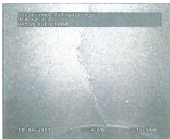
Zdjęcie: D.6_D.7_180411_150554_A.JPG 15,56m, Pęknięcie wzdłużne, o 12 godzina
