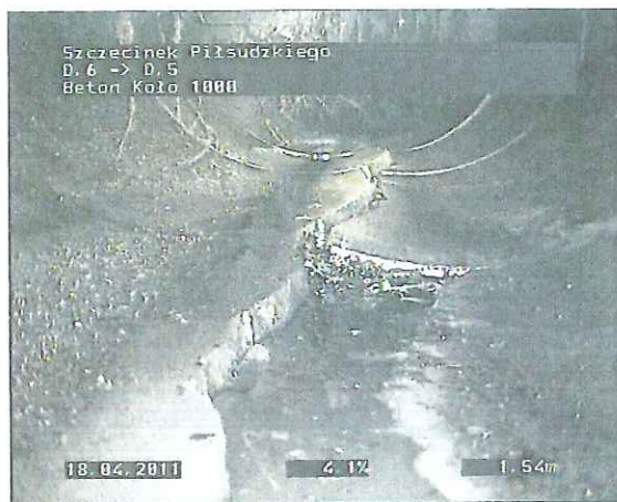
Zdjęcie: D.6_D.5_180411_135036_A.JPG 1,54m, Wyłom wzdłużny, o 06 godzina
